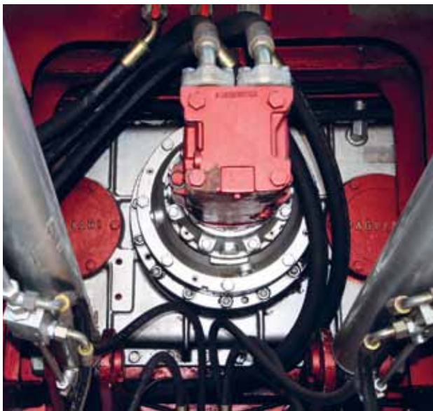
Centraal de hydraulische aandrijving van de onderste vijzels. Links en rechts de cilinders van de laadfrees.
